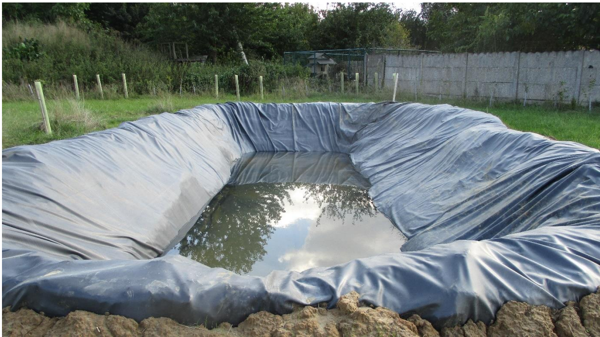
Figuur 3.15. Net aangelegde foliebassin in een agroforestrysysteem (voor totaalplan zie Figuur 5.2). Met dit bassin kan de natuurwaarde van de andere aanwezige natuurlijke poel maximaal gehouden worden, omdat er daar dan geen wateronttrekking nodig is. De taluds worden onder een hoek van 45° geplaatst en de UV-bestendige EPDM-folie wordt rondom rond met de uitgegraven grond vastgelegd. Voor deze wateropslag van 70 m 3 was een omgevingsvergunning nodig. Het nodige irrigatiewater wordt met behulp van een pomp op batterijen (capaciteit 3 m 3 /h) en een tuinslang manueel aangewend voor beregening.
